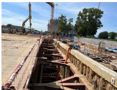
รูปที่ 2.2-5 ระบบป้องกันดินพัง แบบ Sheet Pile ร่วมกับคาน และเสาเหล็ก
